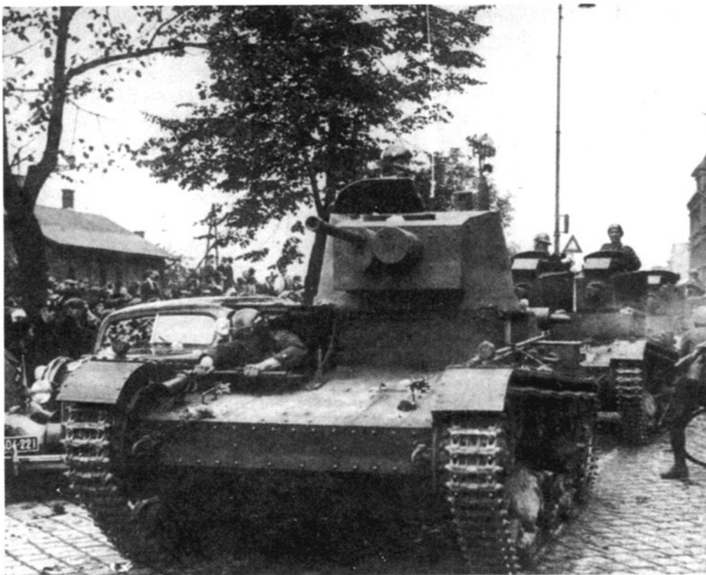
Одно- и двухбашенные танки ТТР. Однотурельный танк оснащен радиостанцией N2С. 1938 г.
