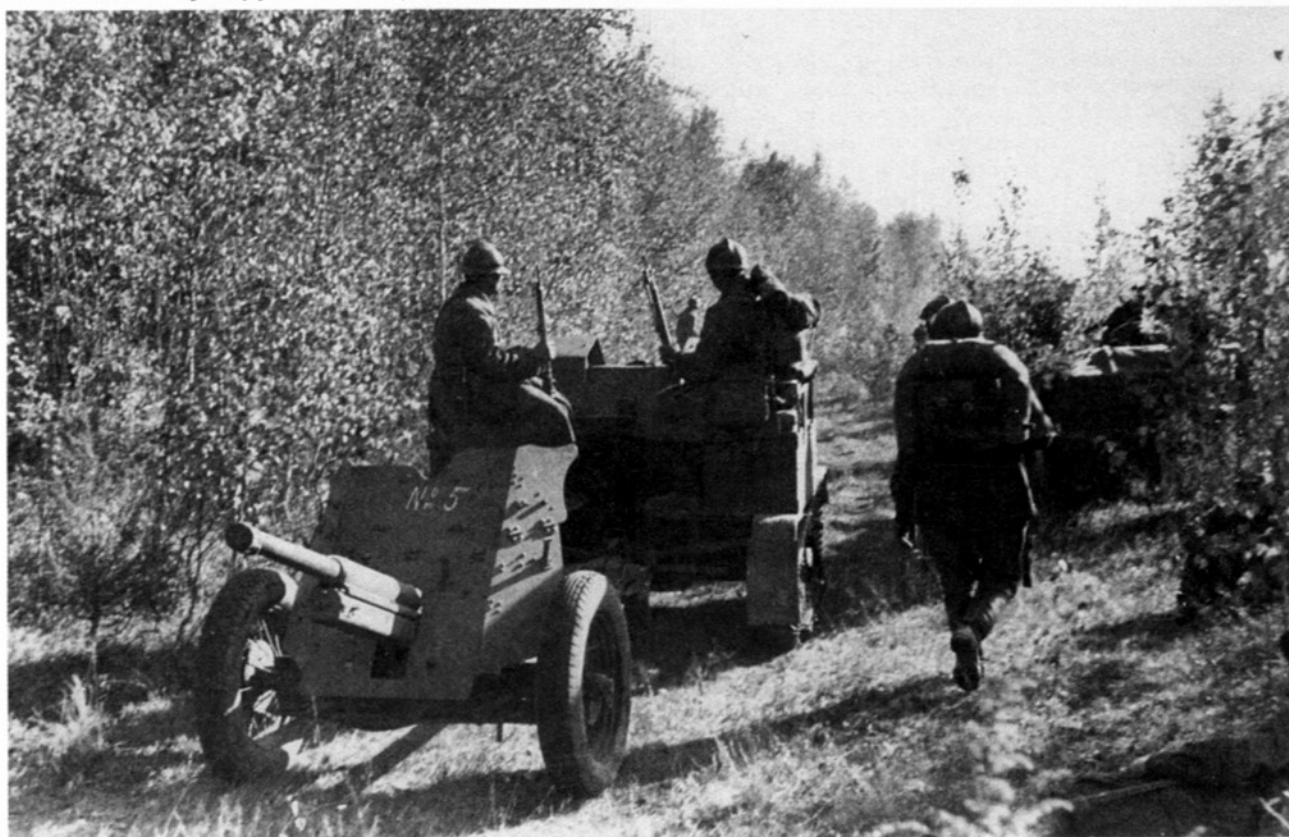
Танкетки Т-27 буксируют 45-мм противотанковые пушки.
